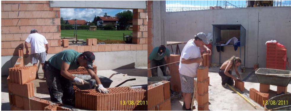
Beim Mauern: Salvatore Scolaro, Stefan Filgertshofer und Paul Rauch
